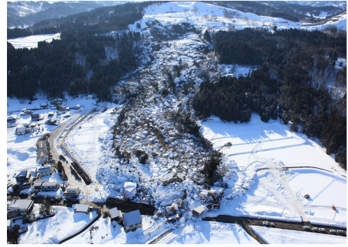
融雪地すべり代表例： 平成25年国川地すべり（上越市）
