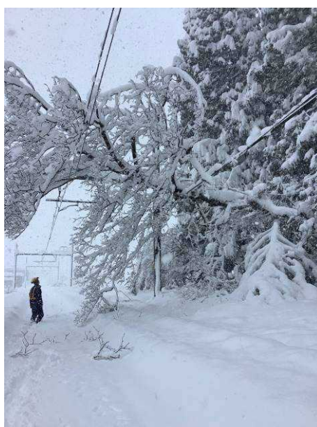
上越線 越後滝谷付近の様子
